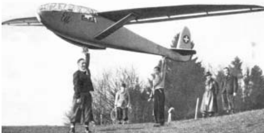
Die Elfe 1, HB-278, wog dank extremer Leichtbauweise nur 43 Kilogramm. Das Capot ist eingestakt. AeroRevue Nr. 5/1941
